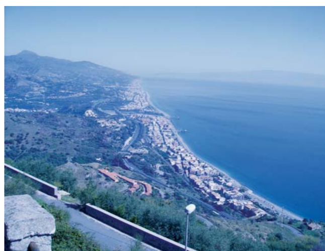
Completata la barriera soffolta a protezione della costa di S. Alessio
